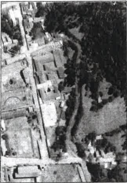
Fotografía N° 1: Vista aérea del Hospital Cangallo
