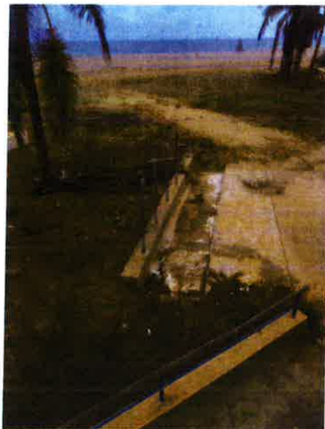
Foto N°20: Duchas existentes en el Malecón de Zorrito en mal estado (Enterradas y sin mantenimiento)
