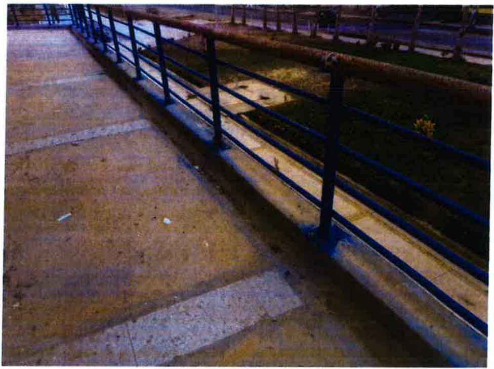
Foto N°29: Pasamanos metálicos en mal estado, con fisuras en la base y corrosión en su estructura.
