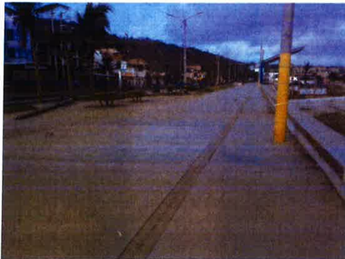
Foto N°22: Pisos de la terraza del Malecón de Zorritos, de cemento pulido y adoquín con fisura y grietas.
