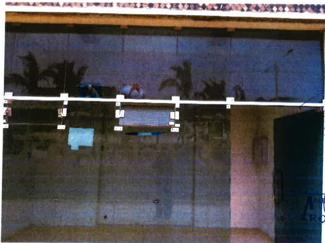
Foto N°09: Puerta y ventanas de cristal faltantes en los diferentes muros cortinas existentes.
