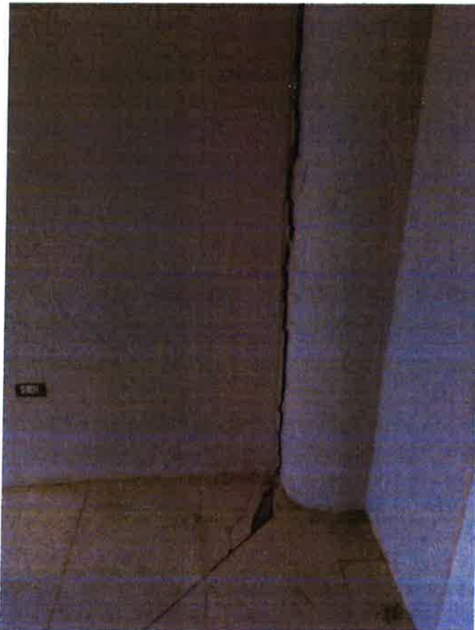
Foto N°07: Junta de dilatación entre columna y muro agrietado.
