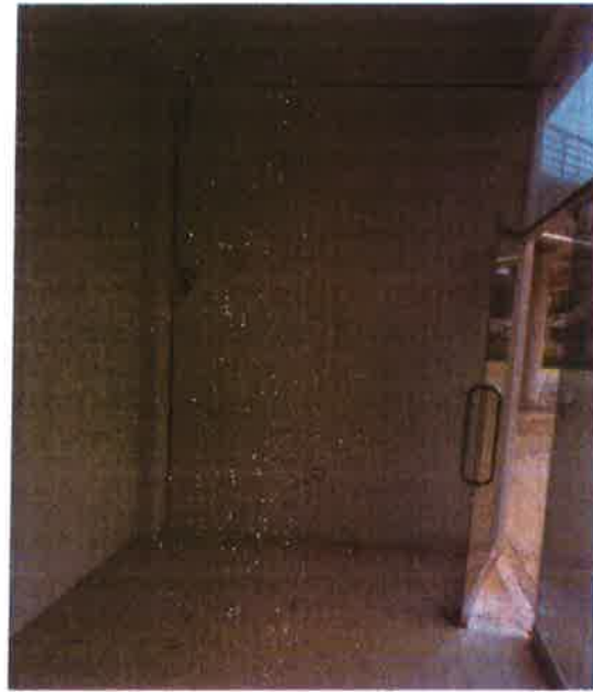
Figura N° 13. Detalle del Desprendimiento entre el tabique y pórtico estructural.
