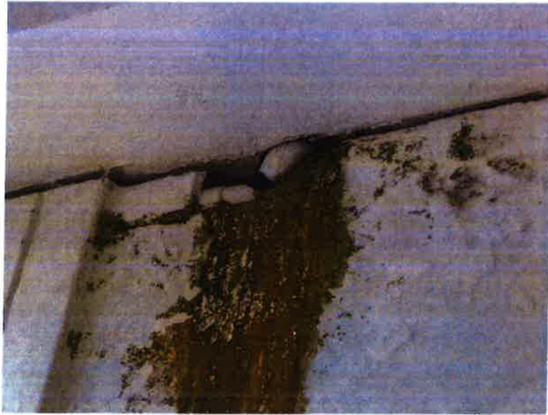
Foto N°06: Instalaciones Sanitarias de desagüe rotos en empalme de losa y muro.
