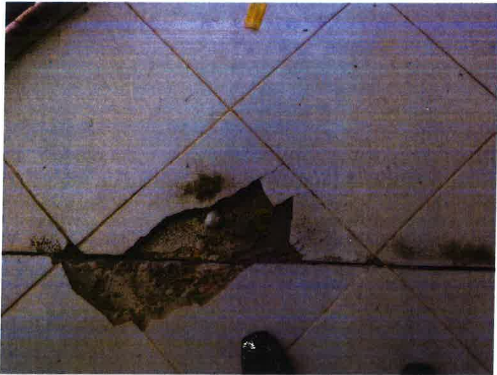
Foto N°04: Pisos de cerámico en estand, en mal estado (Roto y agrietado).
