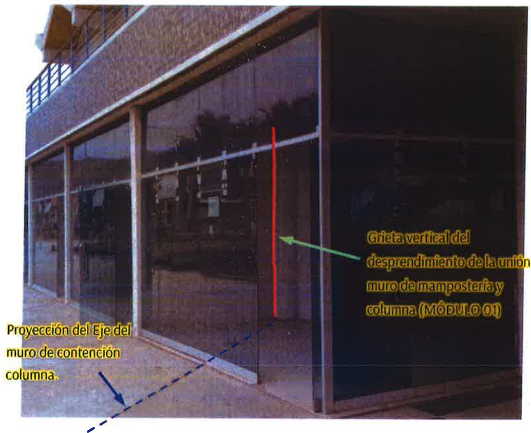
Figura N° 12. Desprendimiento de mampostería del elemento estructural y asentamiento localizado del suelo.
