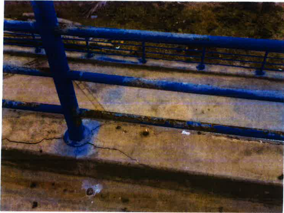
Foto N°27: Pasamanos metálicos en mal estado, con fisuras en la base y corrosión en su estructura.
