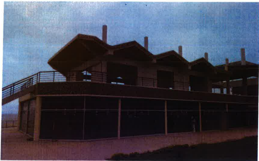
Figura N°1. Vista Frontal de la margen izquierda del Edificio Central.
