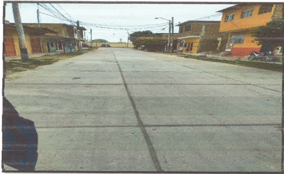
Foto N°08: Pavimento en Buenas Condiciones - Calle Miraflores
