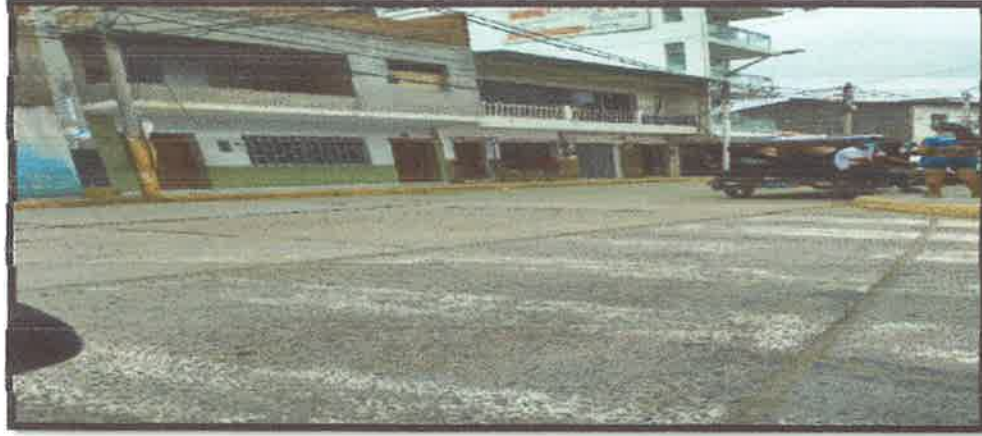
Foto N°10: Pavimento en Buenas Condiciones - Calle Alfonso Ugarte
