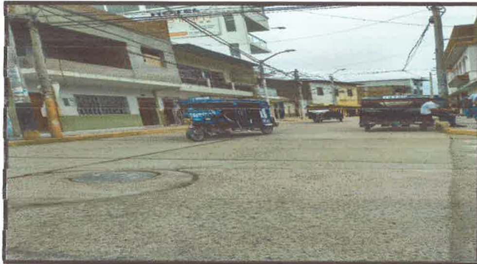
Foto N°11: Pavimento en Buenas Condiciones - Calle Alfonso Ugarte
