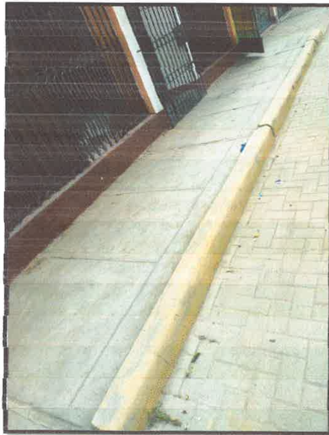
Foto N°08: se puede visualizar que la superficie de las veredas se encuentra en buen estado de conservación.
