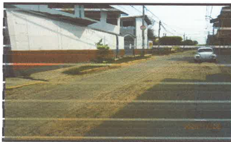
Foto N°01: se puede identificar que las fallas que se presentan, como se observan en la siguiente es deterioro total en tramos, ahuellamiento y desgaste de superficie.
