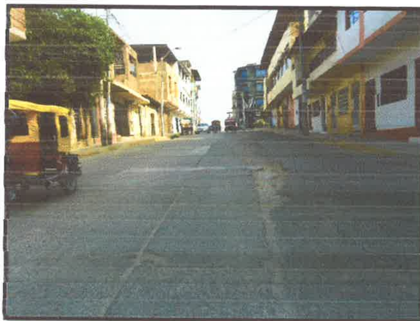
Foto N°05: se puede identificar en la siguiente imagen que existentes agrietamientos, desgaste, asentamientos excesivos, fisuras trasversales entre otros.
