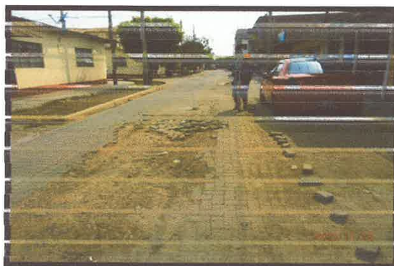
Foto N°01: se puede identificar que las fallas que se presentan, como se observan en la siguiente es deterioro total en tramos, ahuellamiento y desgaste de superficie.
