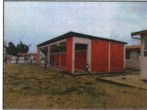
Aulas por Rehabilitar
