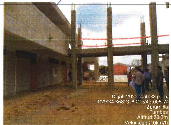
Bloque 6, falta ejecutar acabados y cerramientos
