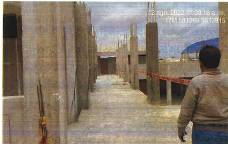
Bloque 5 Circulación, falta ejecutar acabados y cerramientos
