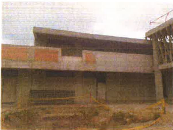
Bloque 11, falta ejecutar acabados y cerramientos
