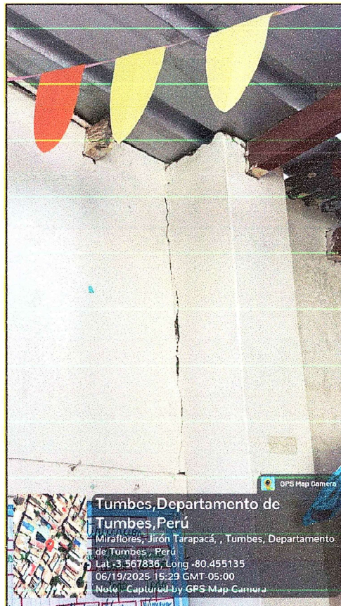
Figura Nº 16: Presencia de grietas entre columna y muro, desgaste por antigüedad.
