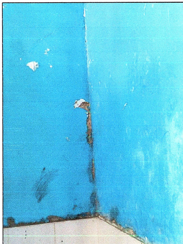
Figura Nº 15: SSHH. Colapsado por resurgimiento de aguas de desagüe.
