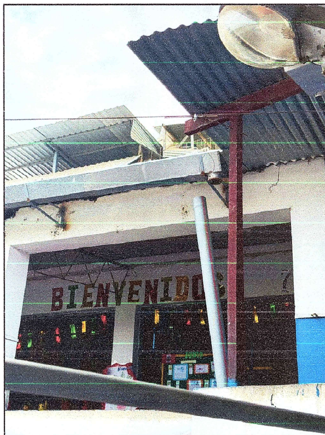
Figura Nº 18: Desprendimiento de la tubería de drenaje pluvial por antigüedad y falta de mantenimiento.
