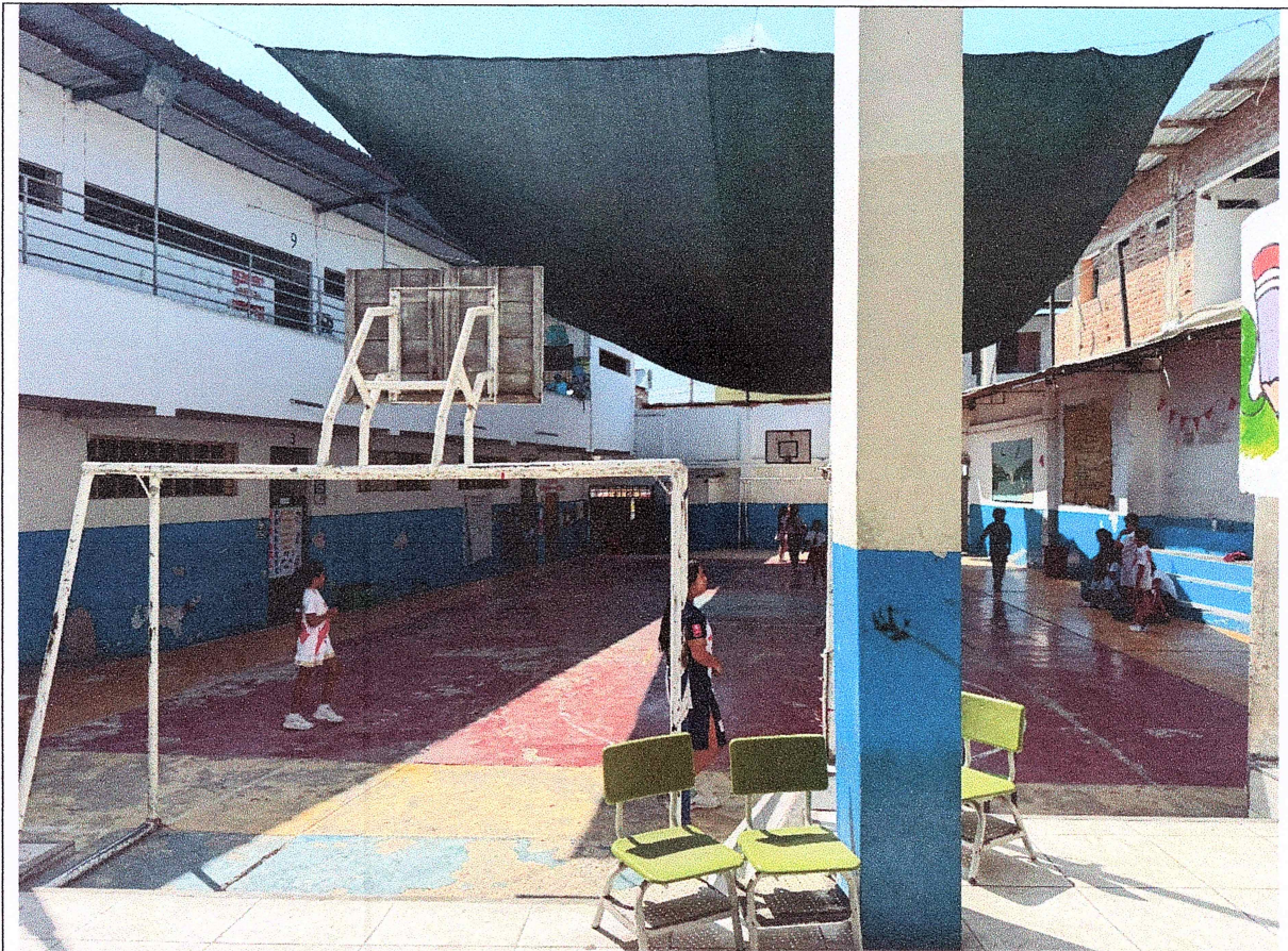
Imagen 1: Interior de la actual institución educativa N° 009 "zoila delgado de quintana" observaciones: estructura general
