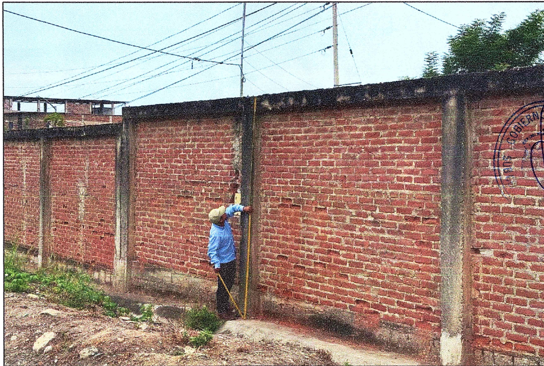
Imagen 02: Otra vista en detalle del muro perimetral a demoler al interior de la I.E N° 117 ROBERTO MEZA CHUNGA.
