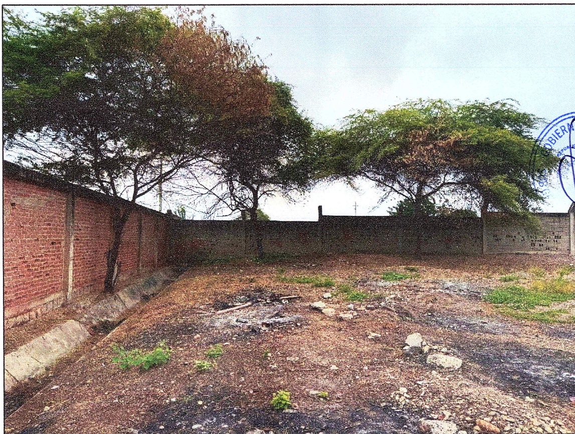
Imagen 04: Otra vista en detalle del área para implementación del plan de contingencia al interior de la I.E N° 117 ROBERTO MEZA CHUNGA.
