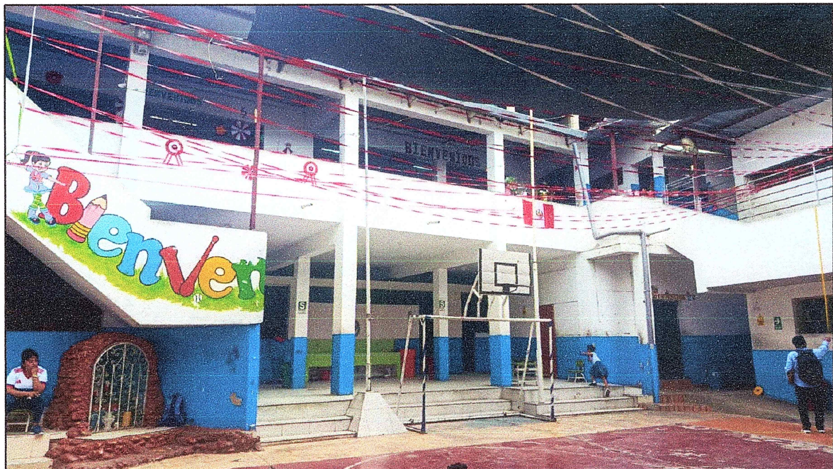
Imagen 06: Otra vista de la parte interna de la I.E. N 009 ZOILA DELGADO DE QUINTANA, para el proyecto de mejoramiento.
