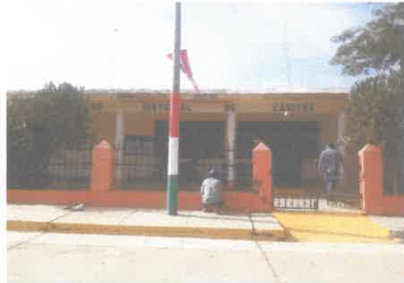
Municipalidad Distrital de Casitas - Cañaverall
