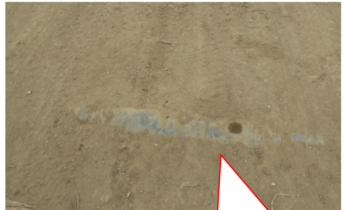
Exposición de tubería de regadío, con potencial colapso, que inundaría la estructura de la vía.
