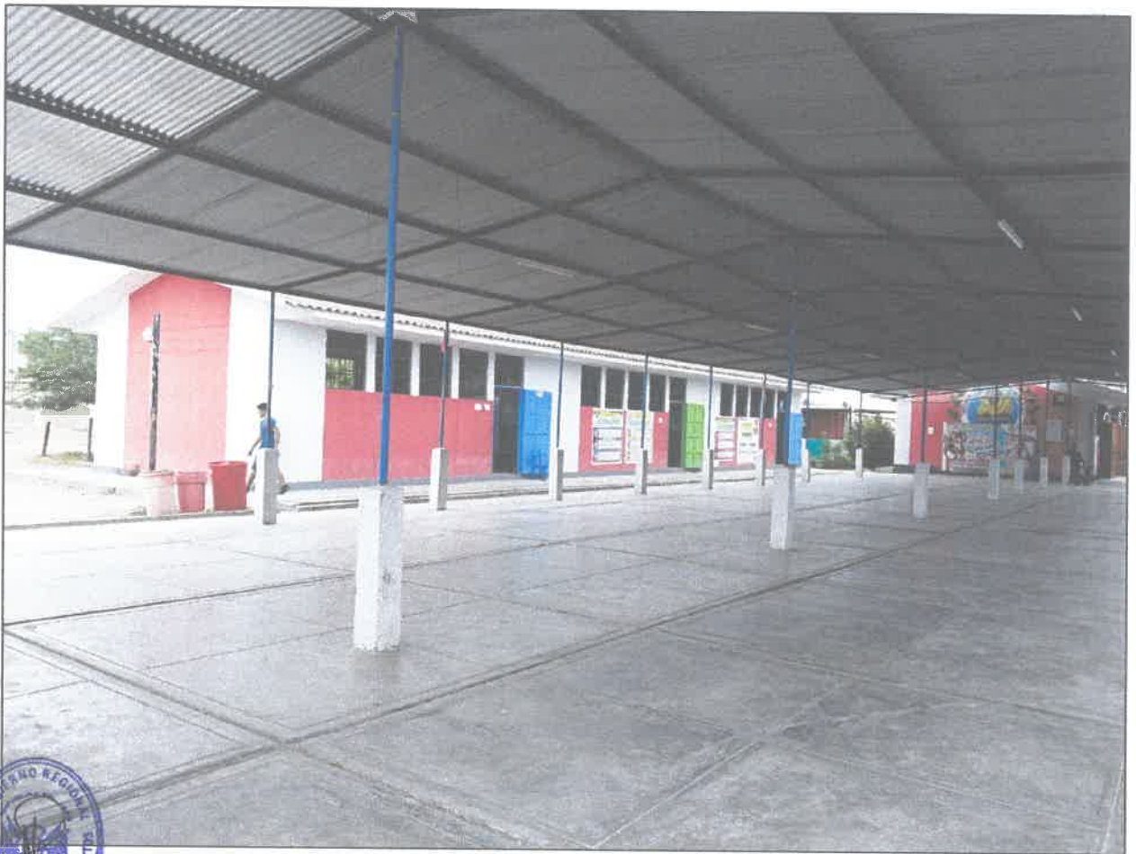
PANEL FOTOGRAFICO N°13: Patio Central
