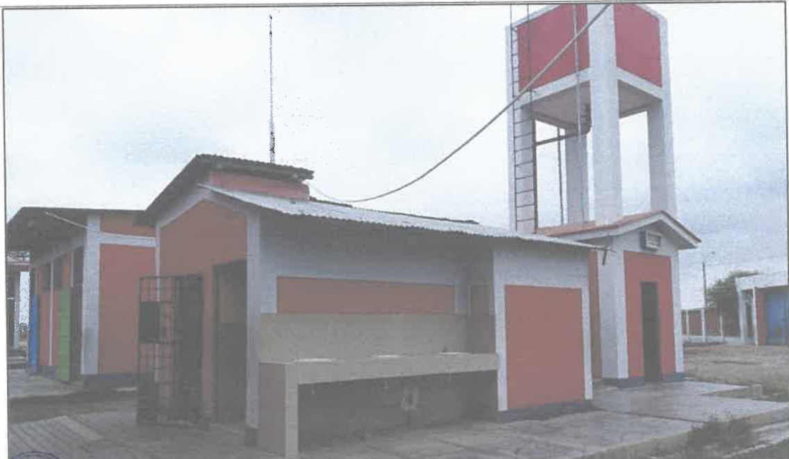
FOTOGRAFIA N°02: Infraestructura construida en el año 2011, en regular estado de conservación
