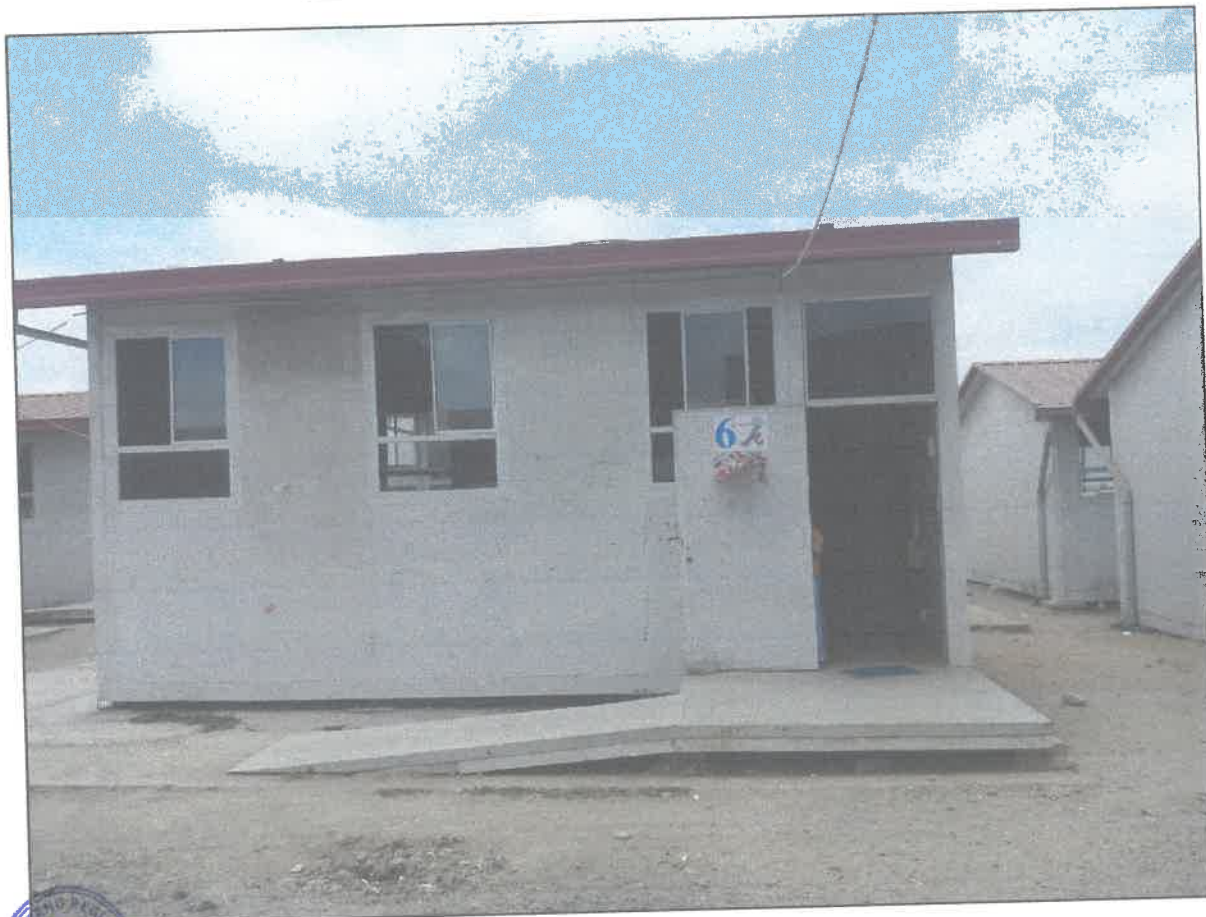
PANEL FOTOGRAFICO N°02: Aulas Pre Fabricadas
