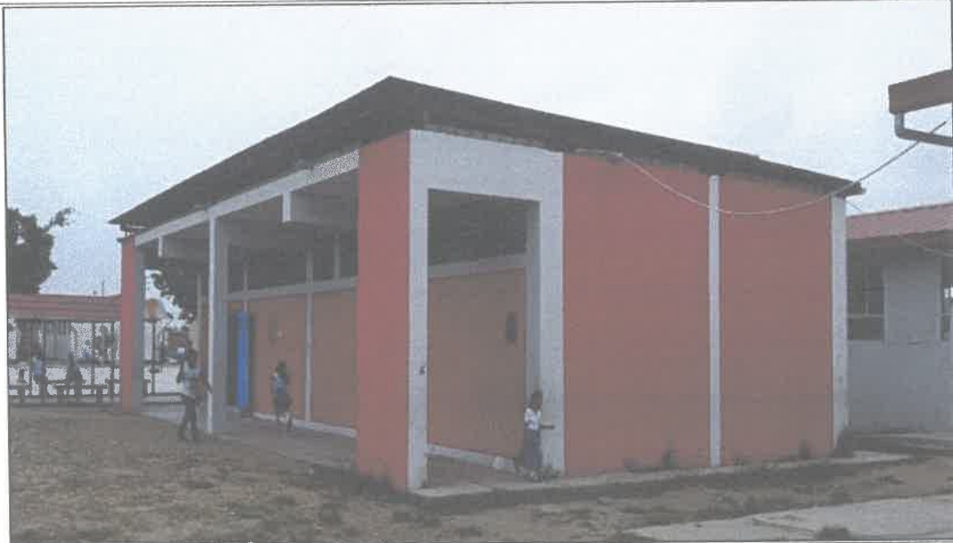
Fotografía N°01: Infraestructura construida en el año 2011, en regular estado de conservación
