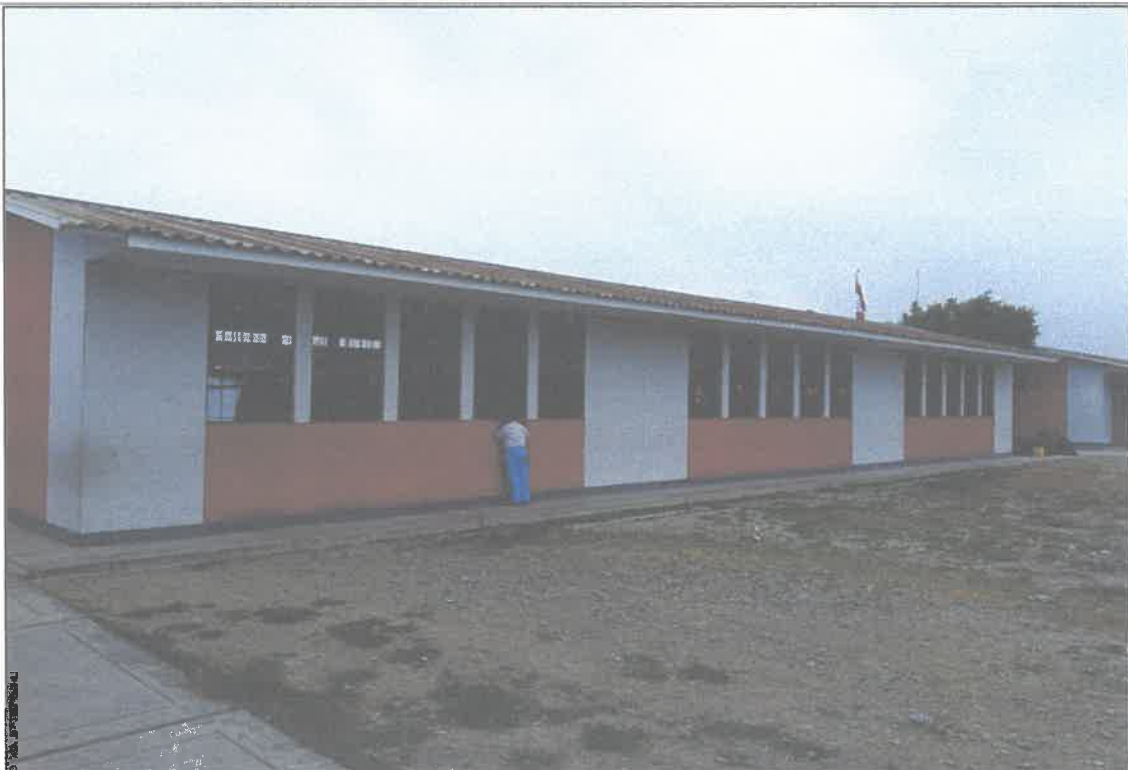
FOTOGRAFIA N°06: Aulas de material pre fabricado con cobertura liviana, instaladas sobre una losa de concreto, construidas en el año 2007, usadas para el dictado de cases de alumnos de nivel primario.
