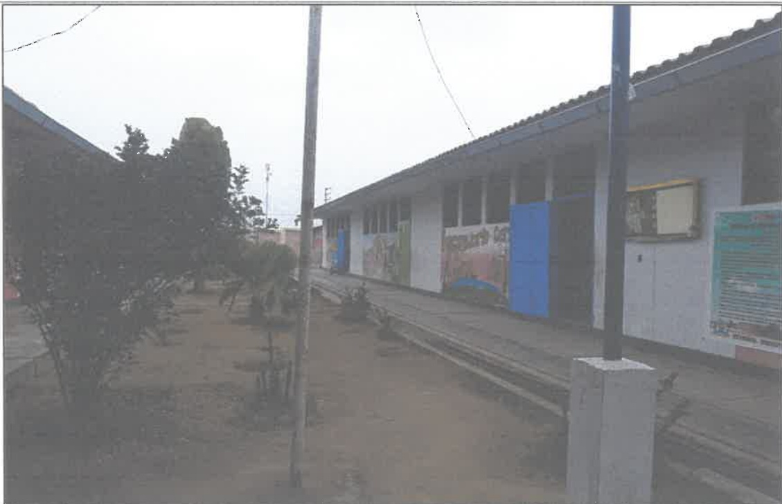
FOTOGRAFIA N°08: Aula de material pre fabricado con cobertura liviana, instaladas sobre una losa de concreto, construidas en el año 2007, usadas para el dictado de clases
