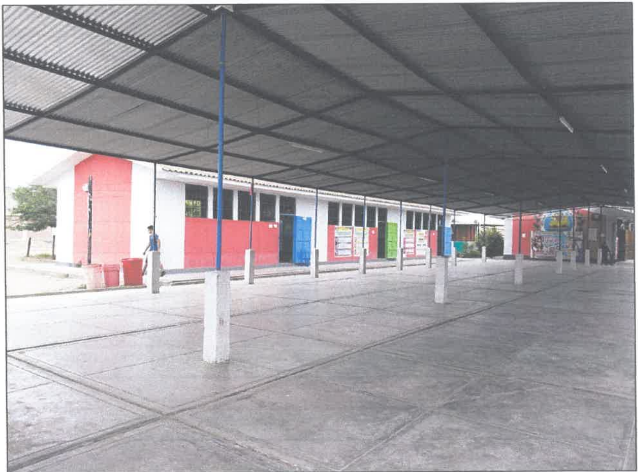
PANEL FOTOGRAFICO N°13: Patio Central
