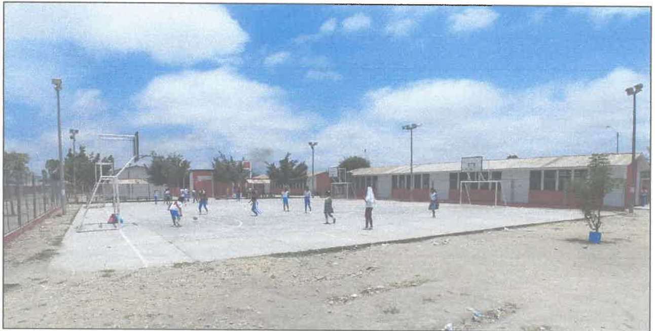
PANEL FOTOGRAFICO N°12: Losas Deportivas
