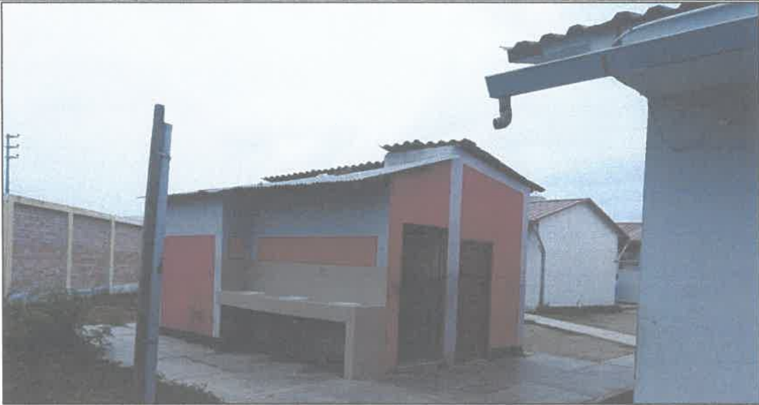
FOTOGRAFIA N°07: Son ambientes de material noble con cobertura liviana, construidas en el año 2007, en mal estado de conservación, habiendo cumplido ya su tiempo de vida útil.
