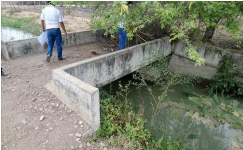
**Fotografía N°02:** se evidencia el mal estado del puente existente, ubicado en la progresiva **1+820**.
