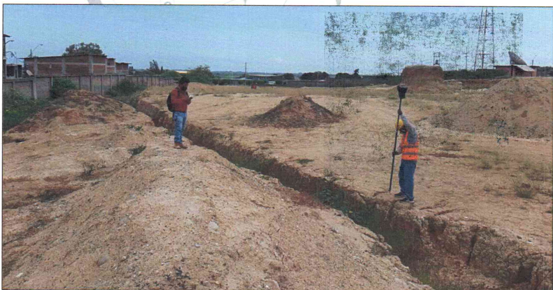
FOTOGRAFÍA N°16: levantamiento de detalles del terreno
