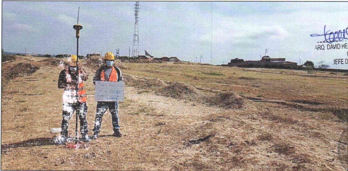
FOTOGRAFÍA N°13: lectura de bm de apoyo
