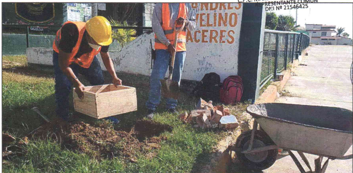
FOTOGRAFÍA N°02: monumentación del punto de control
