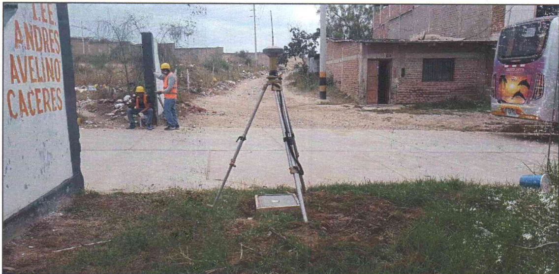
FOTOGRAFÍA N°04: instalación del equipo – gps diferencial
