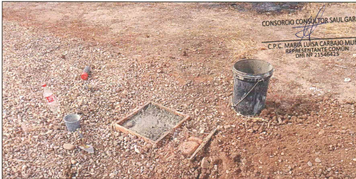
FOTOGRAFÍA N°08: trabajos de monumentacion de punto geodésico
