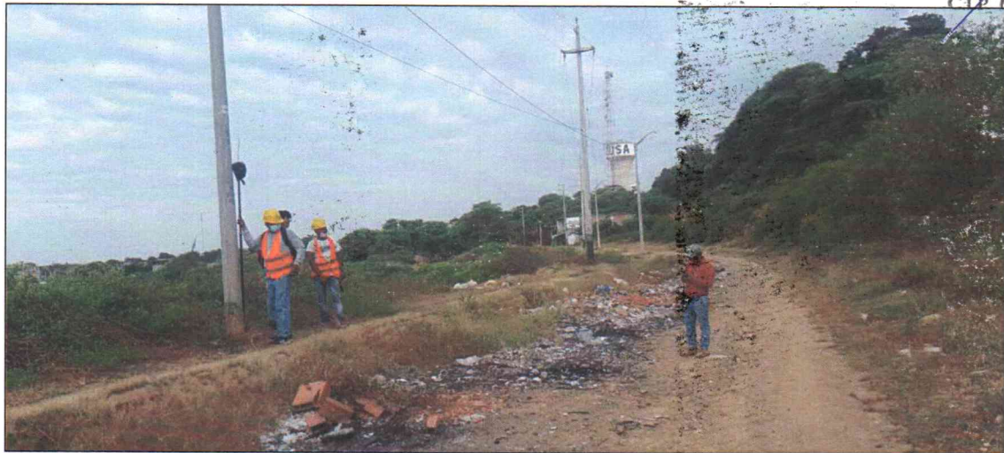
FOTOGRAFÍA N°10: levantamiento topográfico a detalle de postes de luz
