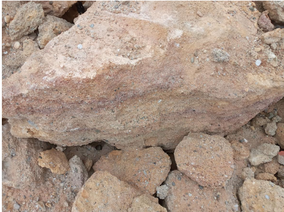
Figura 3-9: Foto de la arena cementada, propenso a sufrir colapso.
