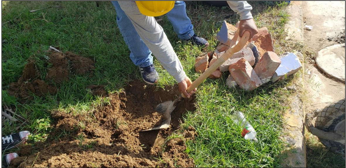
FOTOGRAFÍA N°01: trabajos de albañilería tumbes
