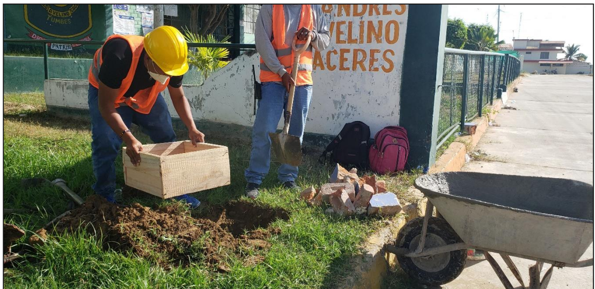
FOTOGRAFÍA N°02: monumentacion del punto de control
