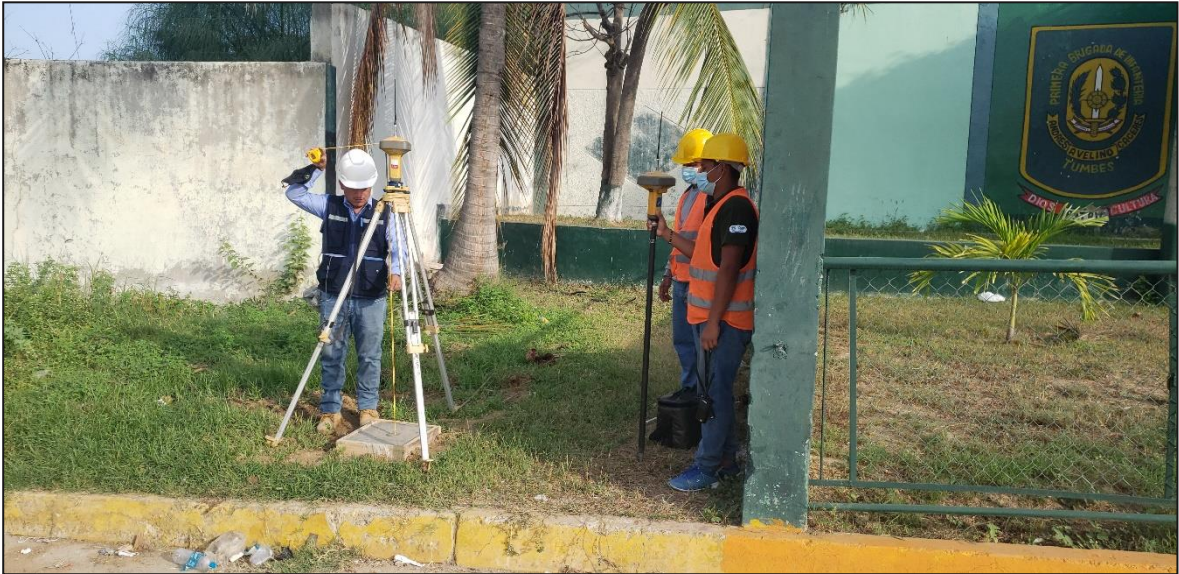
FOTOGRAFÍA N°05: punto de control geodésico control de calidad y verificación
