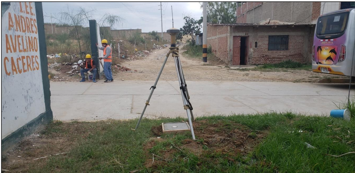
FOTOGRAFÍA N°04: instalación del equipo – gps diferencial
