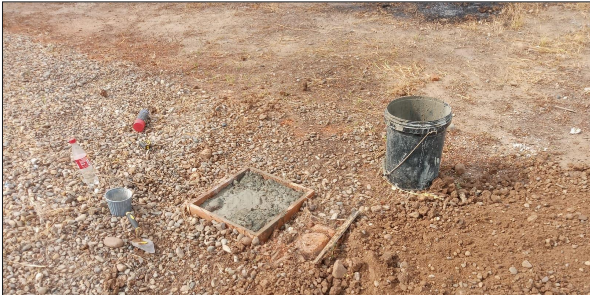
FOTOGRAFÍA N°08: trabajos de monumentacion de punto geodésico
