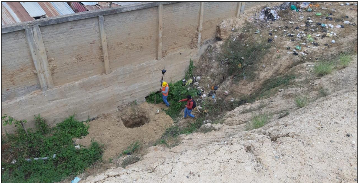
FOTOGRAFÍA N°18: levantamiento de depresiones mas resaltantes del terreno.
