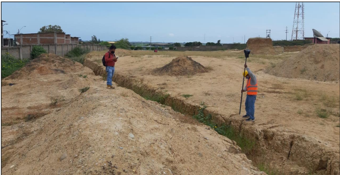
FOTOGRAFÍA N°16: levantamiento de detalles del terreno
