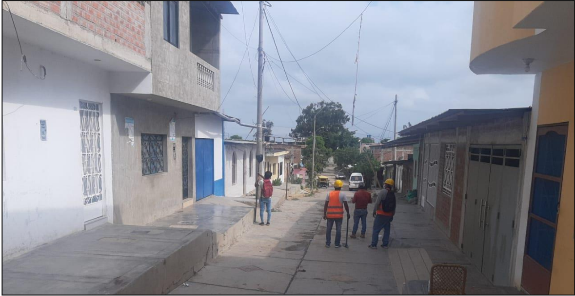
FOTOGRAFÍA N°11: levantamiento topográfico de buzones
