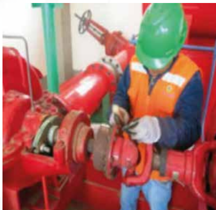
Mantenimiento BCI Cliente: Petroperú
