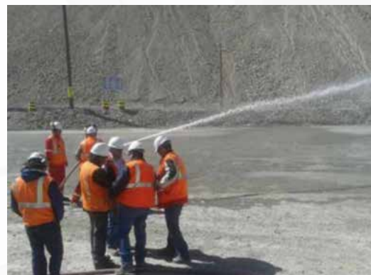
Pruebas de Gabinetes Cliente: Southern Toquepala
