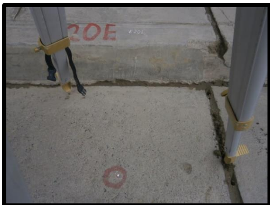
Fig. 11-16.- Monumentación de Estaciones y BM
