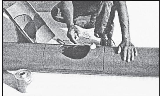
5. Presentar finalmente el accesorio sobre el colector, inmovilizar y presionar mediante zunchos por espacio de 2 horas a fin de lograr una adecuada soldadura entre las partes.
