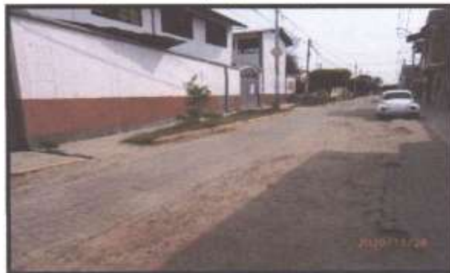
Foto N°01: se puede identificar que las fallas que se presentan, como se observan en la siguiente es deterioro total en tramos, ahuecamiento y desgaste de superficie.
