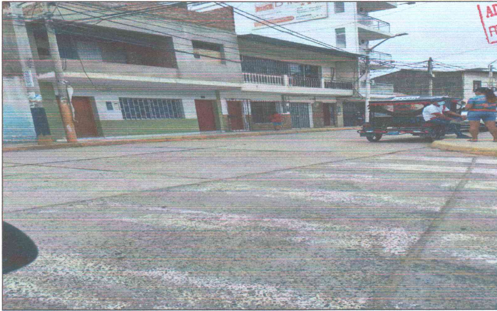
Foto N°010: Pavimento en Buenas Condiciones - Calle Alfonso Ugarte
