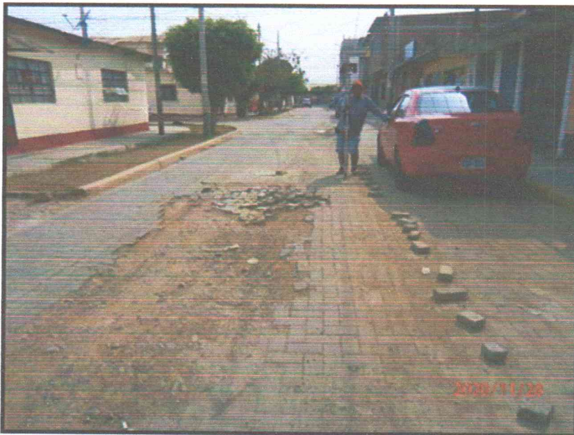
Foto N°01: se puede identificar que las fallas que se presentan, como se observan en la siguiente es deterioro total en tramos, ahuellamiento y desgaste de superficie.
