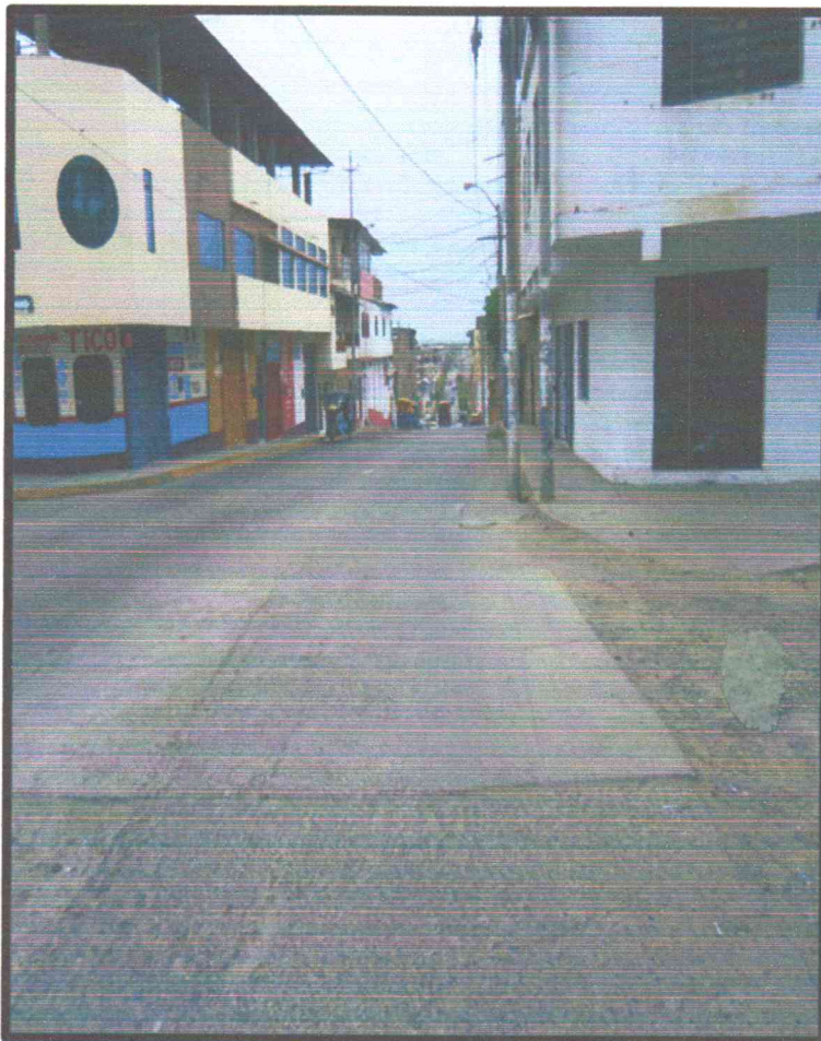
Foto N°06 y 07: se puede identificar en la siguiente imagen que existentes desgastes en la losa de rodadura, desplazamiento de paños, agrietamiento entre otros.
