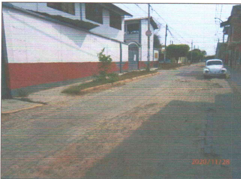
Foto N°01: se puede identificar que las fallas que se presentan, como se observan en la siguiente es deterioro total en tramos, ahuellamiento y desgaste de superficie.
