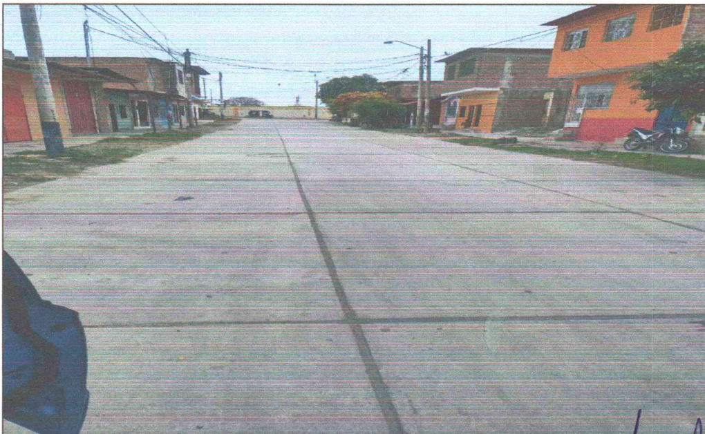
Foto N°08: Pavimento en Buenas Condiciones - Calle Miraflores
