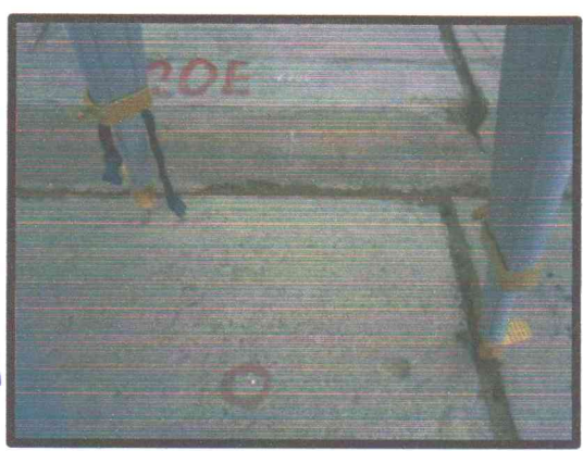
Fig. 11-16.- Monumentación de Estaciones y BM
