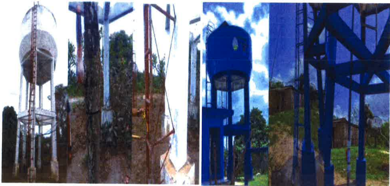
Antes de la intervención
