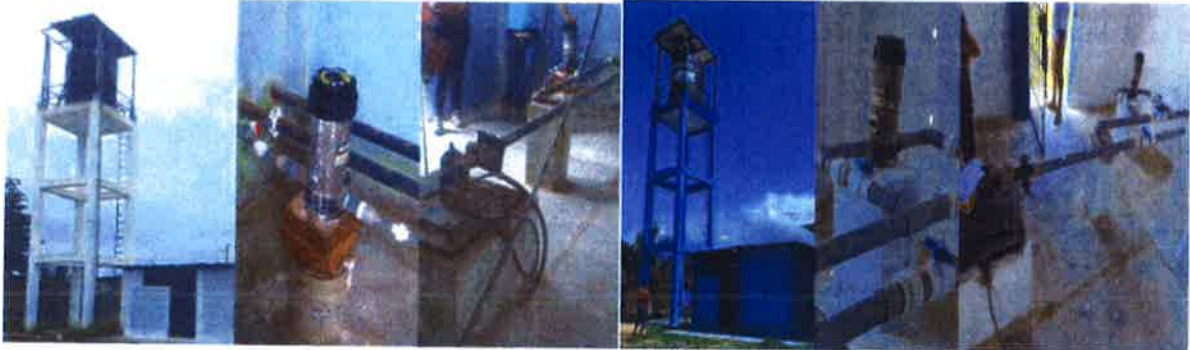
Antes de la intervención
