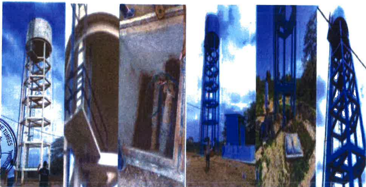
Antes de la intervención
